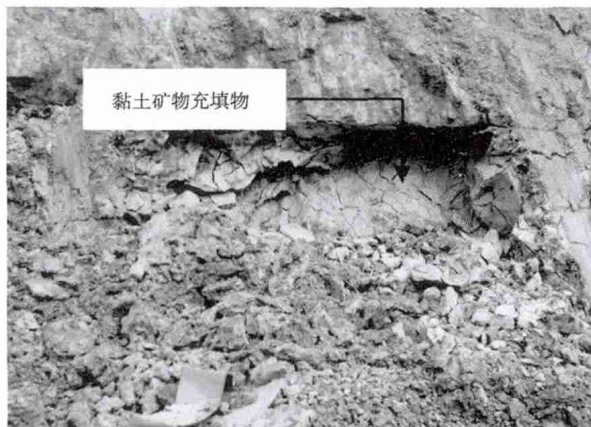
图3 充填黏土矿物的裂隙面
