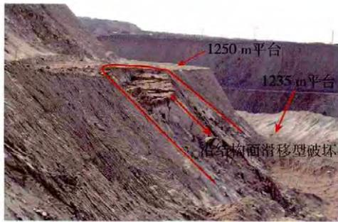
图 11 6#边坡 1250 m 平台滑移破坏
